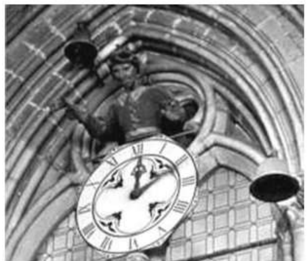
FIGURA 2. El papamoscas, autómata de la catedral de Burgos que se acciona con la coincidencia horaria.
